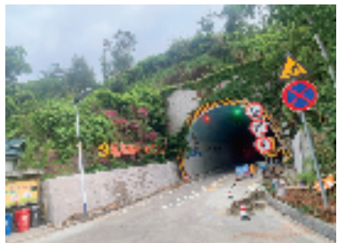
▲改造前的隧道
